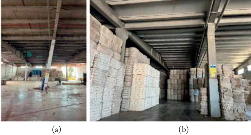
Şekil 1. (a) Deprem sırasında önemli ölçüde şekil değiştirmeye maruz kalmış prefabrik betonarme kolon (45 x 45 cm) (b) hasar yaşanmamış kolon (60 x 60 cm)
